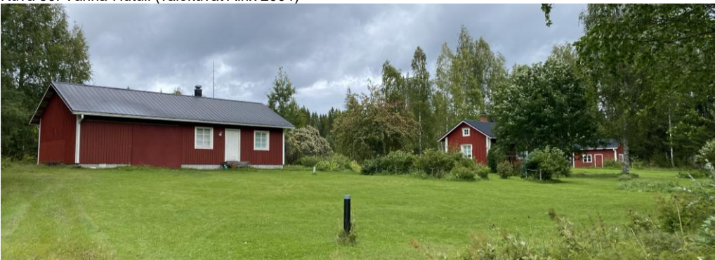
Kuva 31. Vanha-Hutuli, etualalla uudempi talousrakennus (valokuva Sweco 2025)
