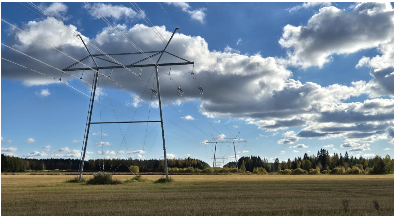
Kuva 45. Elenian voimajohto suunnittelualueen lounaislaidalla.
