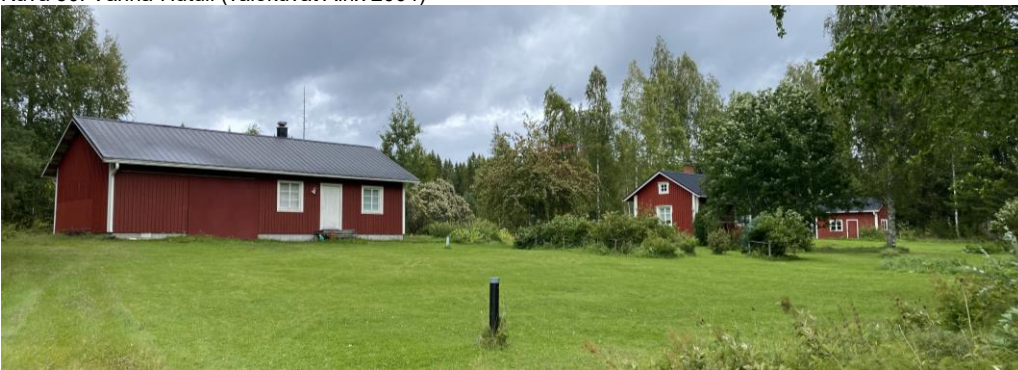
Kuva 31. Vanha-Hutuli, etualalla uudempi talousrakennus (valokuva Sweco 2025)
