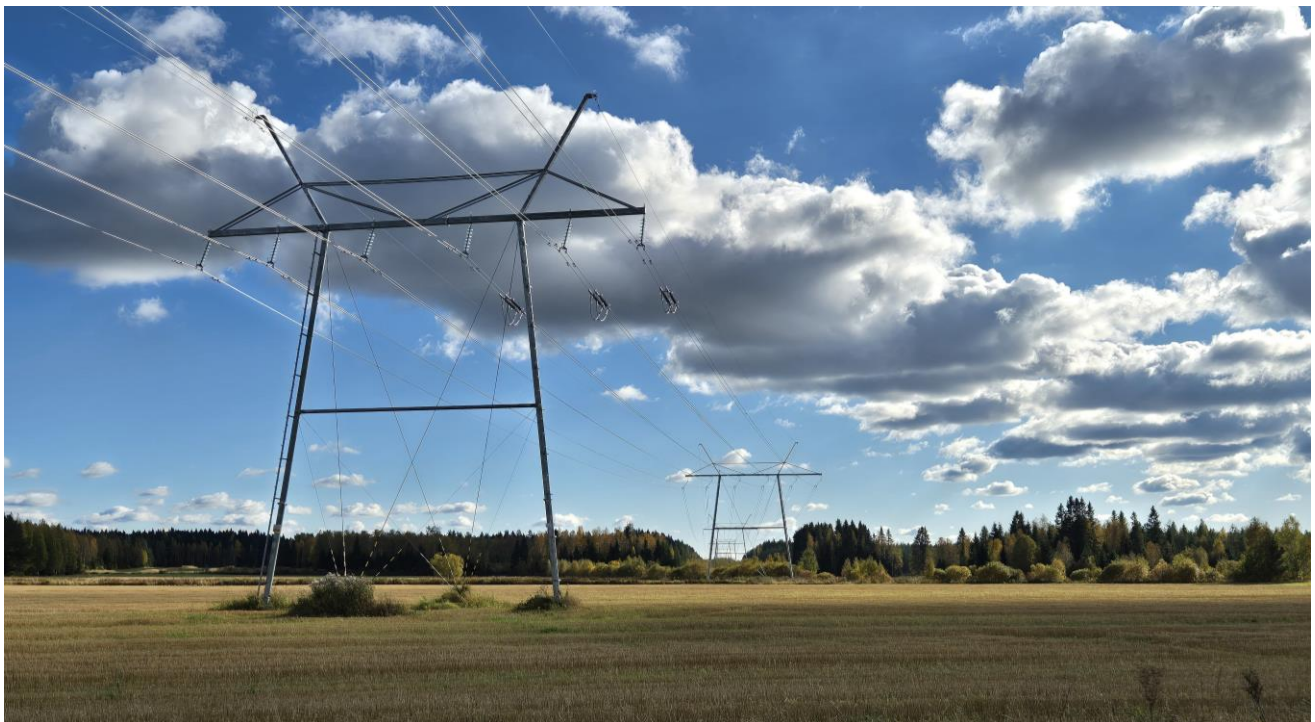
Kuva 45. Elenian voimajohto suunnittelualueen lounaislaidalla.
