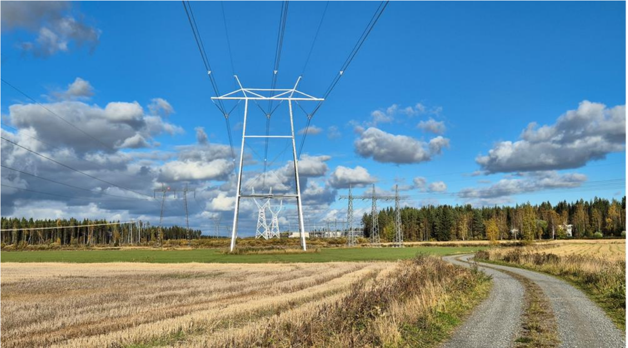
Kuva 3. Suunnittelualan voimajohtoverkoston. Taustalla Pysäysperän sähköasema.
