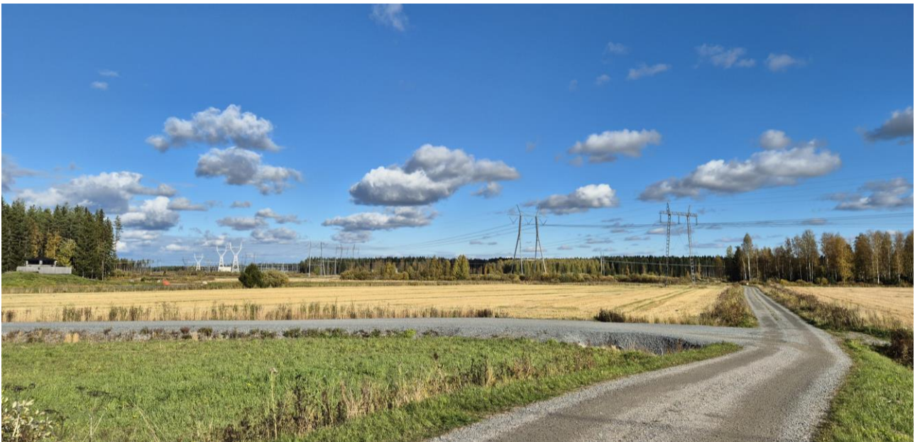
Kuva 1. Pysäysperän sähköaseman eteläpuolisen alueen maisemaa.
