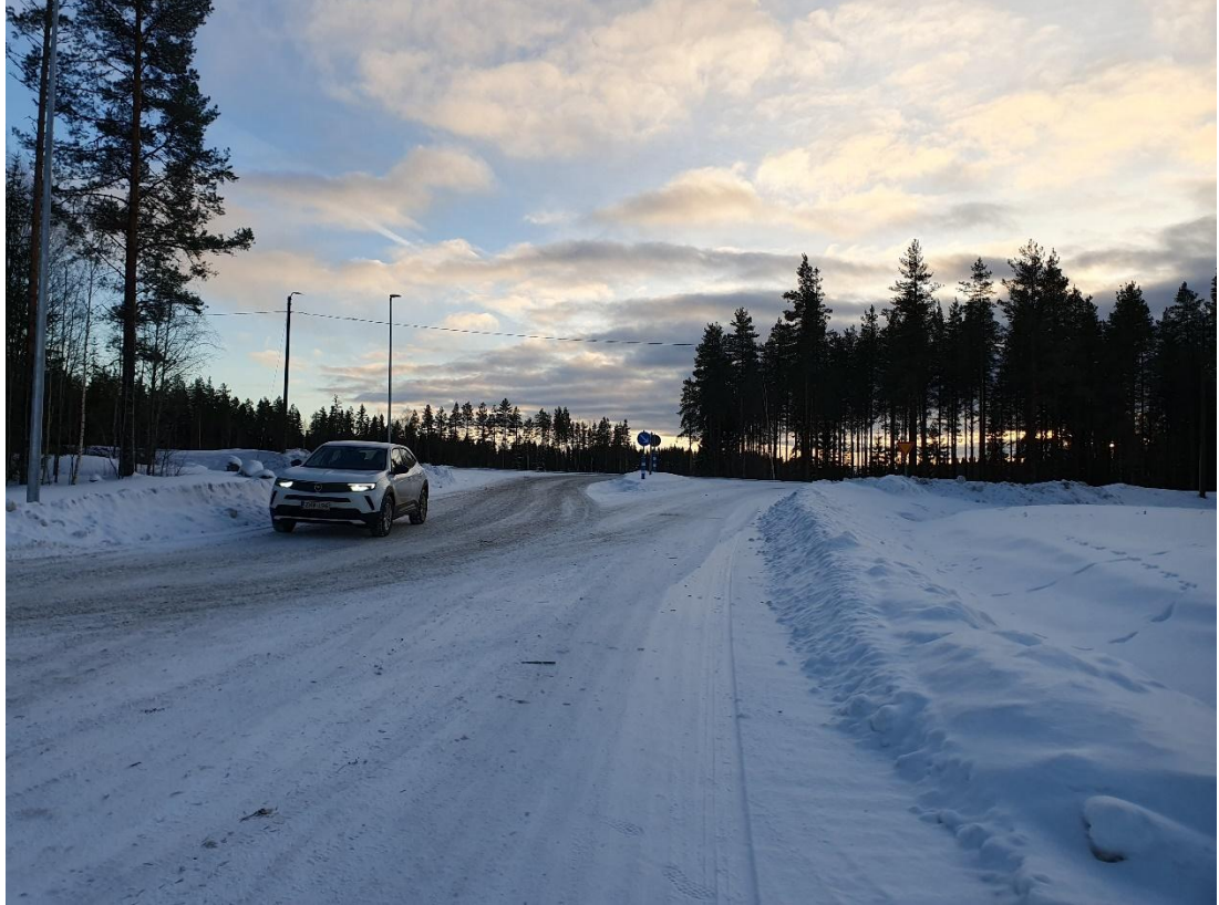
Kuva 8 Valokuvassa Hallakankaantien ja Pyhäjärventie (valtatie 27) risteysalue Hallakankaantieltä kuvattuna. Risteyksessä on kanavointi.
